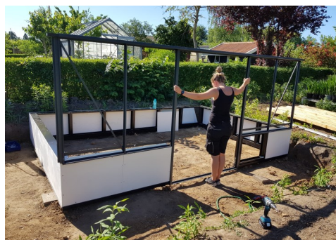
Drivhusets dele samles og monteres på den etablerede halvmur.
