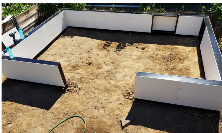
3) Fibercementpladerne skrues på profiltrammerne indvendig og udvendig.
