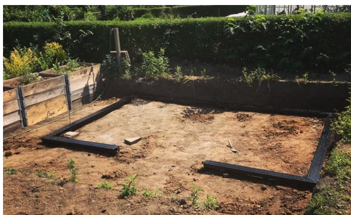
1) Fundamenttrammen placeres, nivelleres og punktstøbes.
